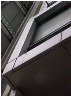
φωτ.11 Λεπτομέρεια όψη
