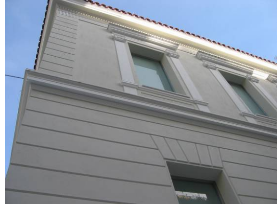
φωτ.19 : όψη από οδό Χαλίων
