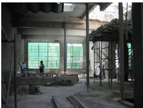
φωτ.6 : όροφος κτιρίου χώρος με φωταγωγό
