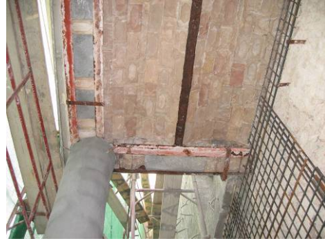
φωτ.9 : ενίσχυση εξωτερικής όψης
