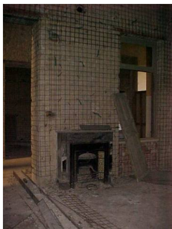
φωτ. 1 : χωλ στο ισόγειο
