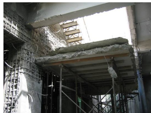
φωτ.7 : πλάκα μηχανολογικών
