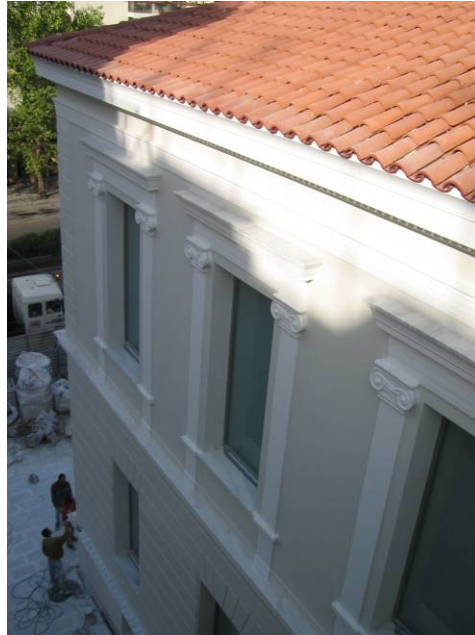
φωτ.20 όψη από οδό Χαλίων
