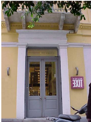
φωτ. 1 Εξωτερική όψη
