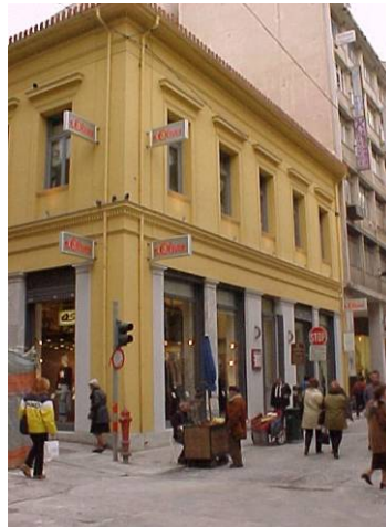
φωτ. 2 Εξωτερική όψη
