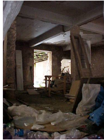
φωτ.9 εσωτερικό ισόγειου
