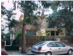
φωτ. 1 Εξωτερική όψη
