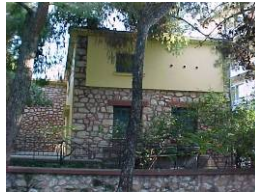
φωτ. 2 Εξωτερική όψη
