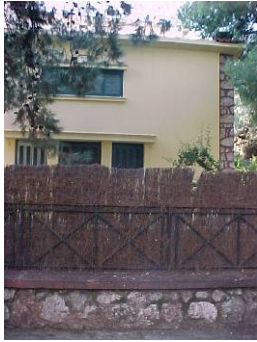
φωτ. 4 Εξωτερική όψη
