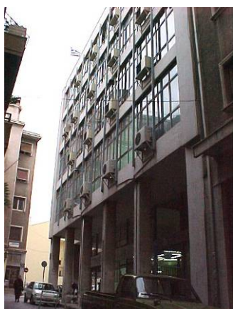
φωτ. 1 Εξωτερική όψη-Υπατίας
