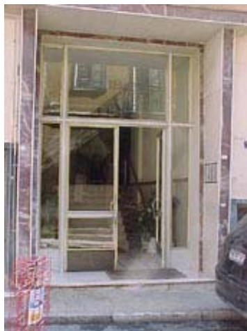
φωτ.3 : είσοδος πολυκατοικίας
